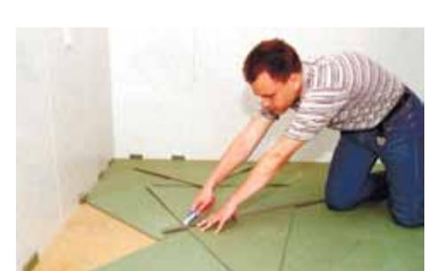
толще и, как следствие, эффективнее по теп-ло- и звукоизоляции. А если вы хотите ис-пользовать свои обои или вагонку, но нужна теплозвукоизоляция на стенах, воспользуй-тесь плитами ISOPLAAT толщиной 25 мм. Они являются своеобразной альтернативой гипсокартону или звукоизолирующей развяз-кой под ним, но в 2 раза легче и существен-но добавят стена姆 теплозвукоизоляции. Их легко крепить на стены без каркаса с помо-щью монтажной пены, а потом шпатлевать.
