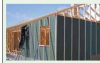
Поверх плиты ISOPLAAT ставим вертикальные рейки, тем самым достигая полной герметичности здания. Прибиваем вагонку и красим.
