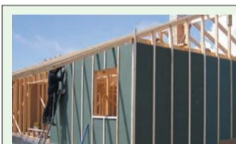
Поверх плиты ISOPLAAT ставим вертикальные рейки, тем самым достигая полной герметичности здания. Прибиваем вагонку и красим.
