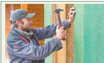
Ветрозащитная плита ISOPLAAT толщиной 12 мм соответствует 44 мм дерева. Крепится непосредственно к поверхности наружных стен деревянного дома.
