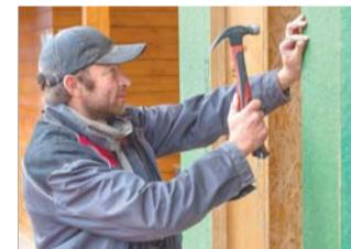
Ветрозащитная плита ISOPLAAT толщиной 12 мм соответствует 44 мм дерева. Крепится непосредственно к поверхности наружных стен деревянного или каркасного дома.
