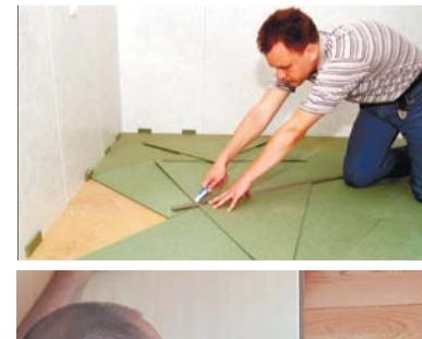
Утепляем пол плитой 12 мм или хвойной подложкой ISOPLAAT толщиной от 4 до 7 мм. Будет служить как тепло- и звукоизоляция ламината или линолеума и выравнивание бетонной стяжки.
