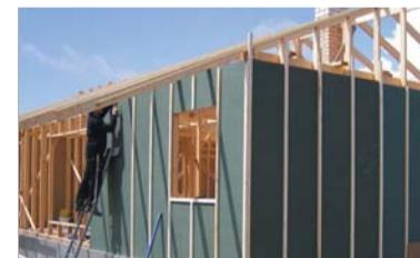
Поверх плит ISOPLAAT ставим вертикальные рейки, тем самым достигая полной герметичности здания. Штукатурим или прибиваем вагонку.
